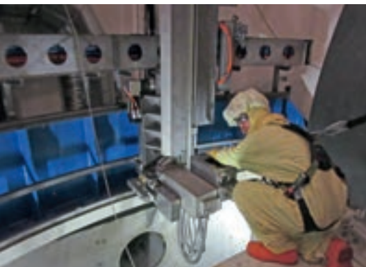
Check des Brennschneidmastes
