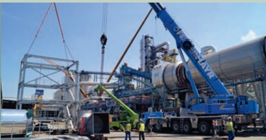
Stahlbau für den neuen Stromrohr-Vortrockner am Kranhaken, fertig für die Montage
