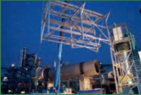
Der vorbereitete Stahlbau für die vier neuen Materialabscheiderzyklone termingerecht in der Luft ...
