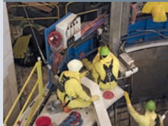
Installation des Brennschneidmastes
