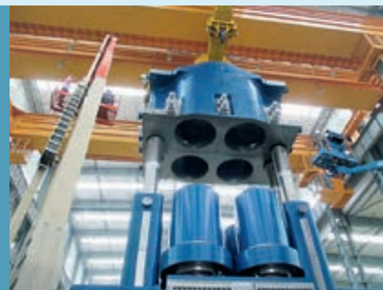
Aufsetzen eines Oberholmsegments der 500-MN-Press
