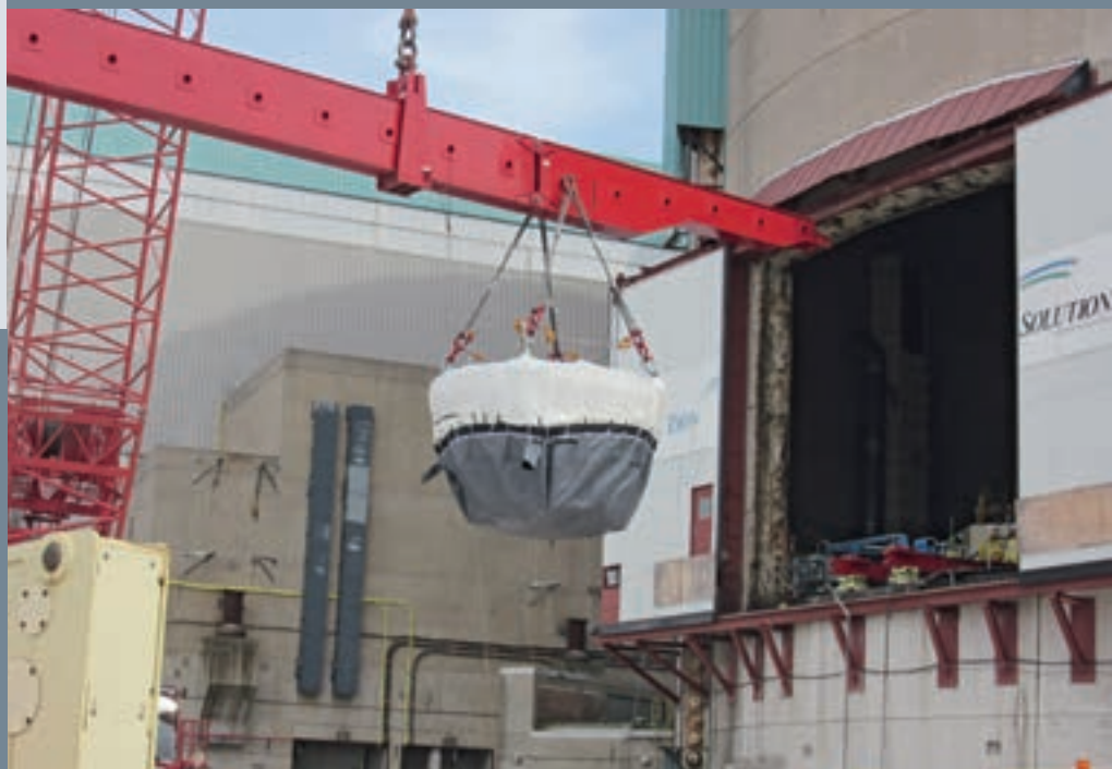
Herausheben der Kalotte der Unit 2
