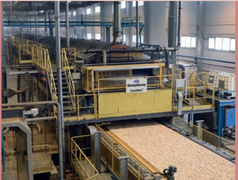
Herzstück der Anlage
