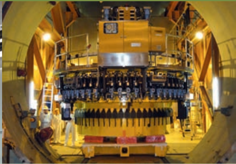
KKW Gravelines 2011: Transport der MST durch die Materialschleuse ins Containment
