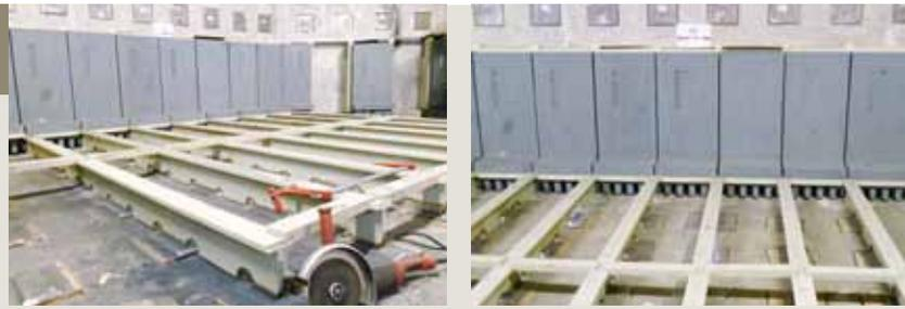
Bodenstahlkonstruktion der Core-Catcher-Kühlstruktur
