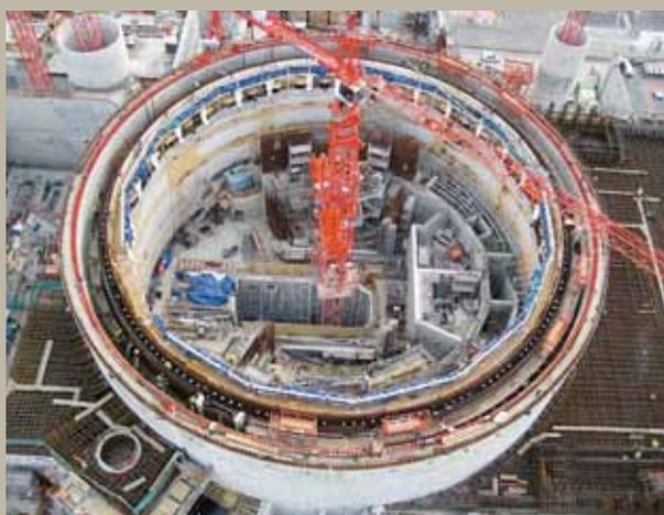
Reaktorgebäude im Bau – tief im Innern wird die Core-Catcher-Kühlstruktur montiert
