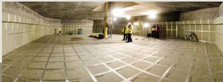
2009: fertig montierte Kühlstruktur des weltweiten ersten Core Catchers in Olkiluoto, Finnland
