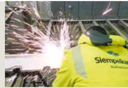
Schweißen der Einzelemente zur Bodenstahlkonstruktion
