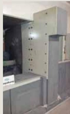
Montierte Transition: Einlaufkanal zwischen Druckbehälterunterseite und Core Catcher zur Weiterleitung von geschmolzenem Material
