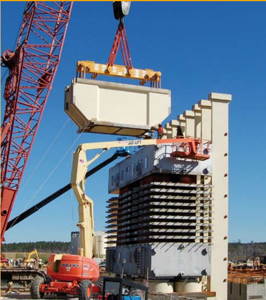
LP Clarc County während der Montage
