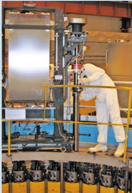
Wartung des Doppeldrehgerätes
