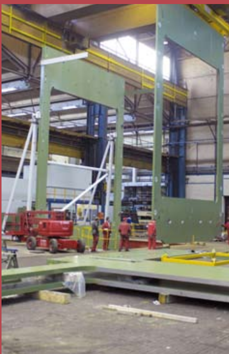
Einbringen der Rahmenbleche
