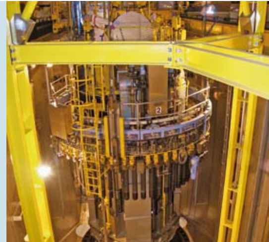
Transport der RDB-Schrauben mit der Schraubenspanmaschine
