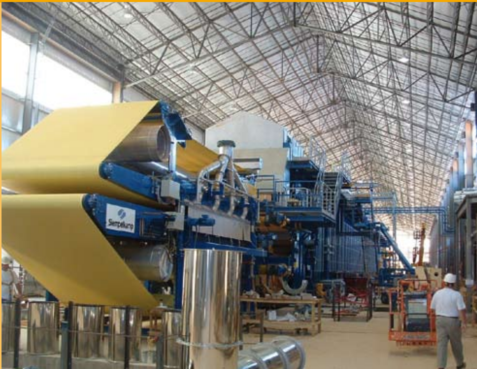
Huber ContiRoll® und Vorwärmung während der Montage
