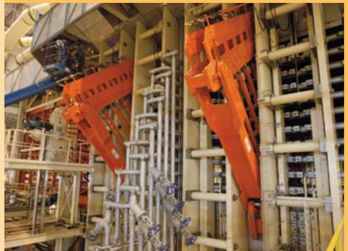
Canfor-LP Mehretagenpresse nach der Fertigstellung
